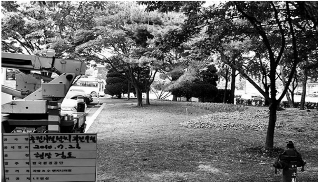
<충전기 설치전 전경(실외)>
