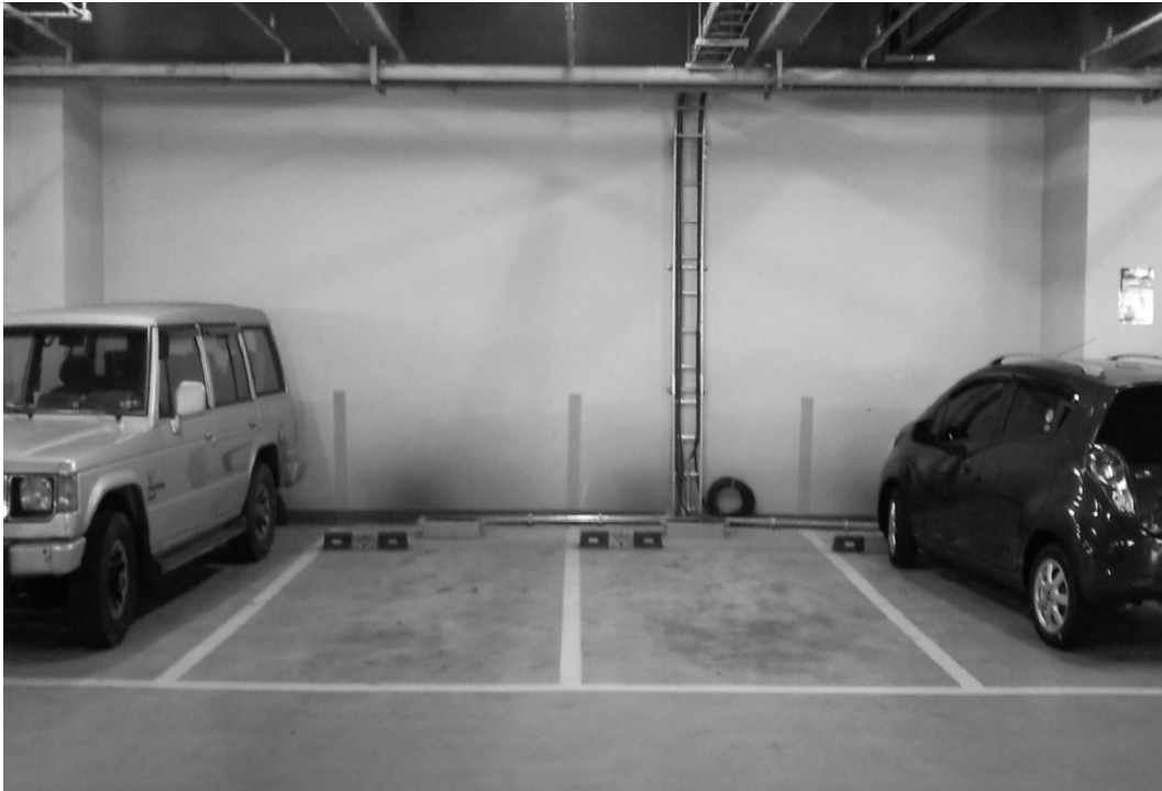
<충전기 설치전 전경(실내)>
